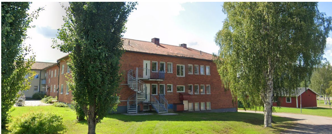
Bild. Byggnad för befintligt äldreboendes norra del innan påbörjad rivning. Bild: Google Maps.
