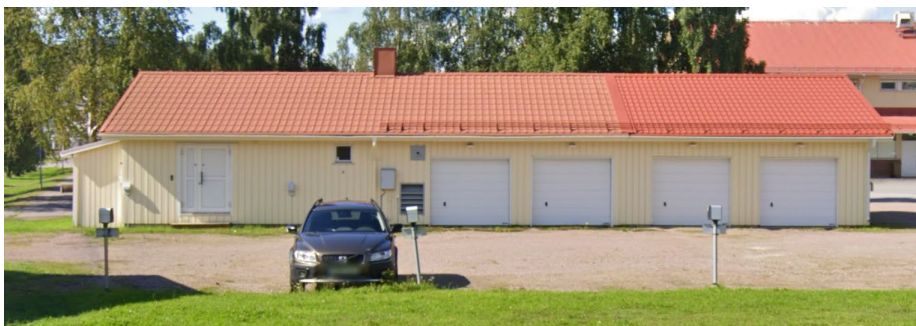
Bild. Garage i planområdets sydvästra del. Bild: Google Maps.
