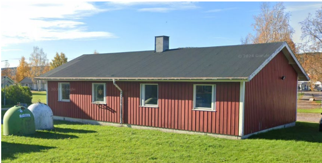
Befintlig samlingslokal innan påbörjad rivning. Bild: Google Maps.
